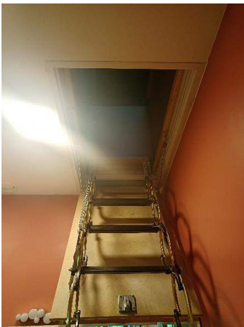
Tarp buto Krivių g 19-2 ir neįrengtos pastogės Krivių g 19-4 tarp perdangos medinių sijų patalpoje Nr 2-2 yra įrengtas liukas
