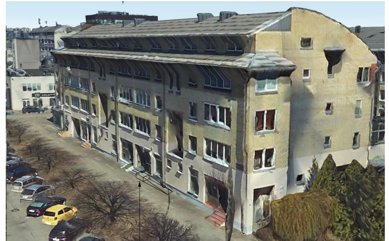
Įėjimas į remontuojamas patalpas. Numatoma ŽN rampa.
