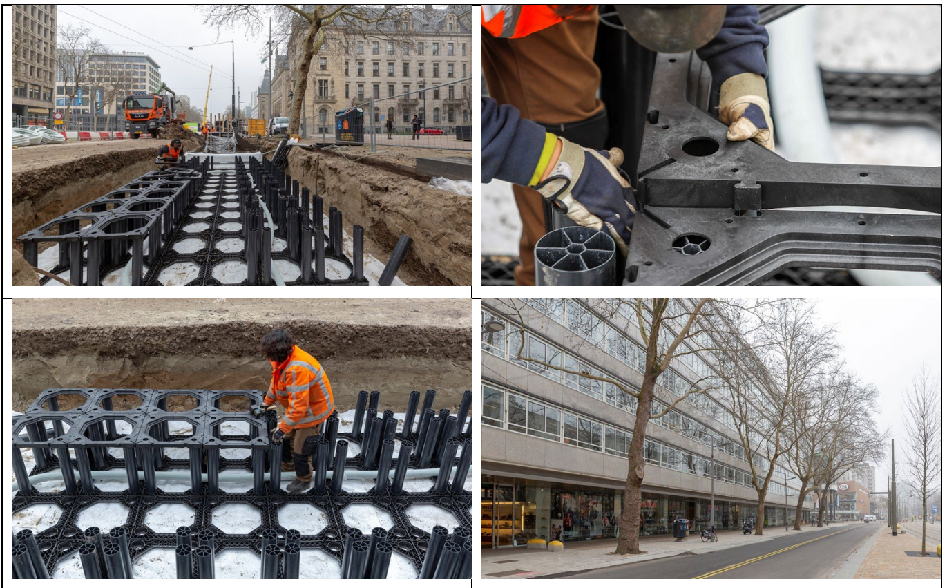
4 pav. Šaknų orinimo sistemos įrengimas, gerinant medžių augimo sąlygas urbanizuotose teritorijose
