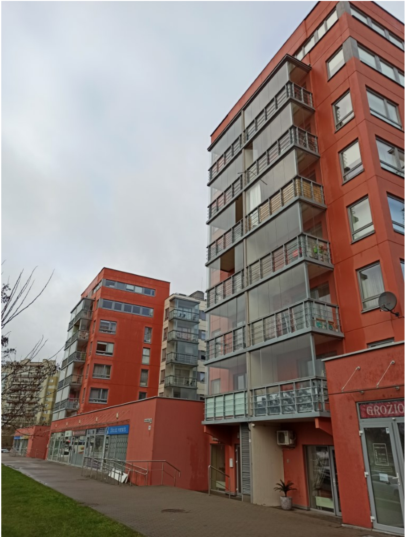
3 pav. Pastato fasadas.
