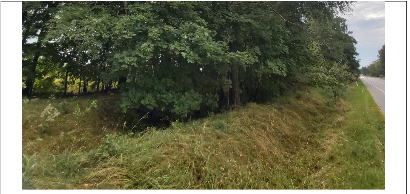
9 pav. Apsauginis griovys skiria kelio želdinių juostą nuo važiuojamosios dalies
