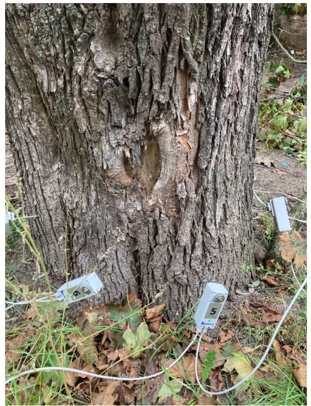
Kamieno mechaninis pažeidimas
