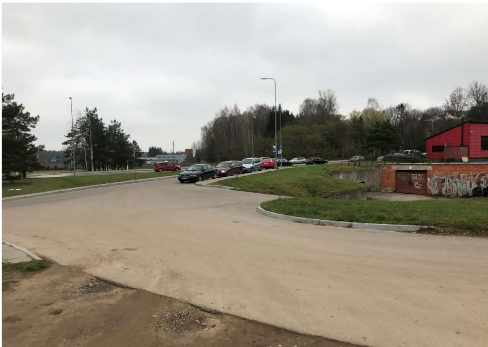
4 pav. Projektuojamos remontuojamos gatvės esama būklė
