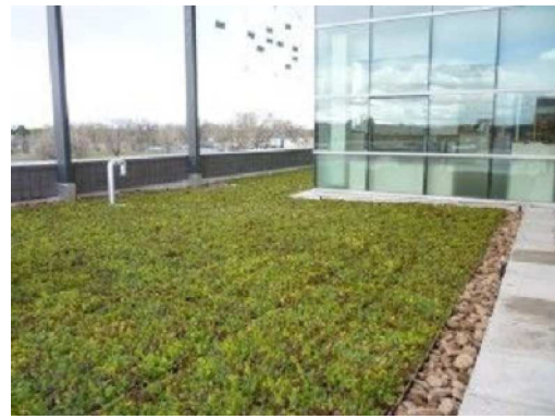
3. 1 AUKŠTO KOMERCINIŲ PATALPŲ STOGAS APŽELDINAMAS
