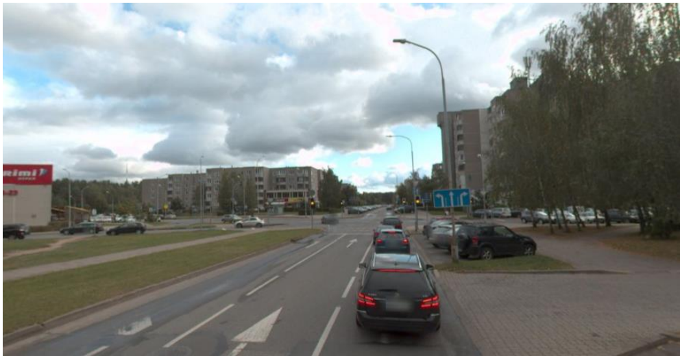
2 pav. Esama gatvės infrastruktūros būklė
