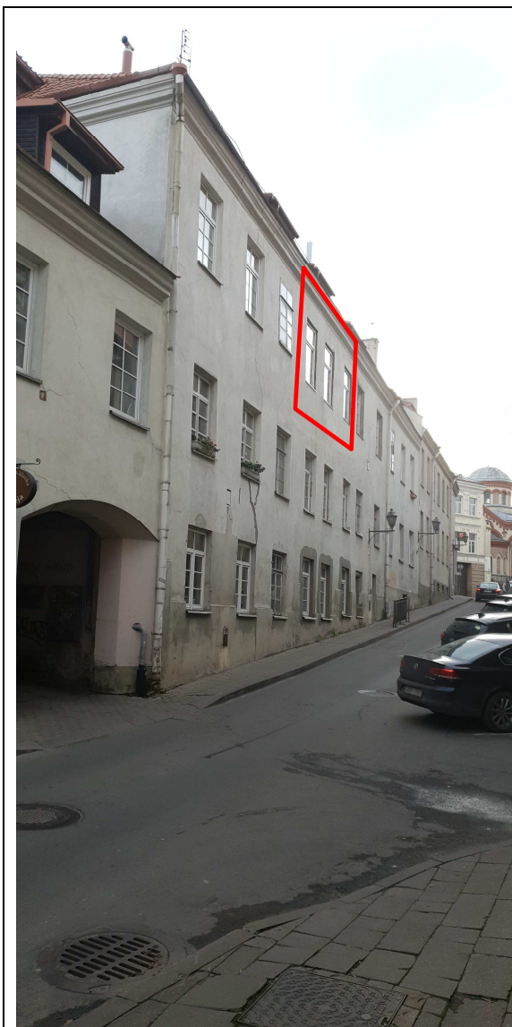
Latako gatvės fasadas nuo Rusų gatvės pusės Pažymėta buto vieta
