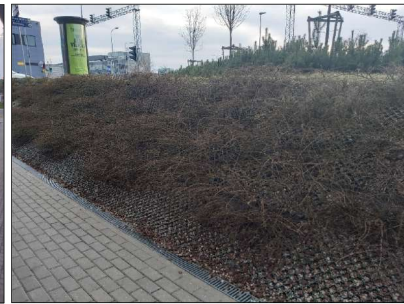
ŠLAITAS TVIRTINTAS SACHMATIŠKAI KOMPUOJUOJANT KORĮ
