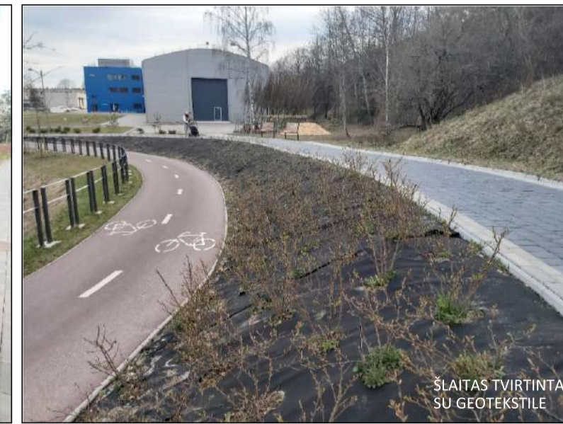
ŠLAITAS TVIRTINTAS SU STAMBIŲ AKIŲ GEOTINKLU
