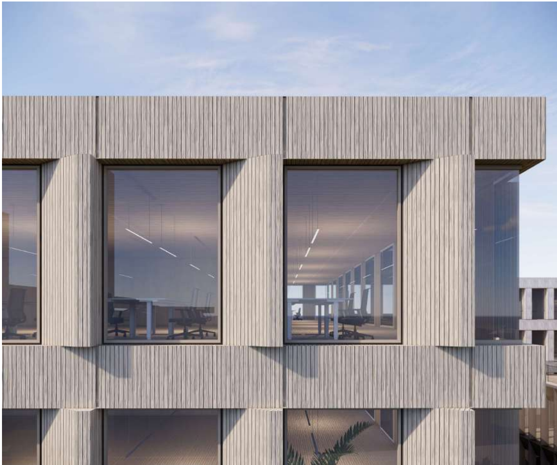
Pav. 46 _A1 ir A2 korpusų fasado apdaila - CLT medžio panelės / medžio dailylentės. Sprendinys tikslinamas techninio projekto rengimo metu
