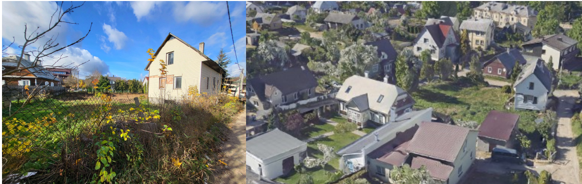
Esanas rekonstruojamas pastatas
