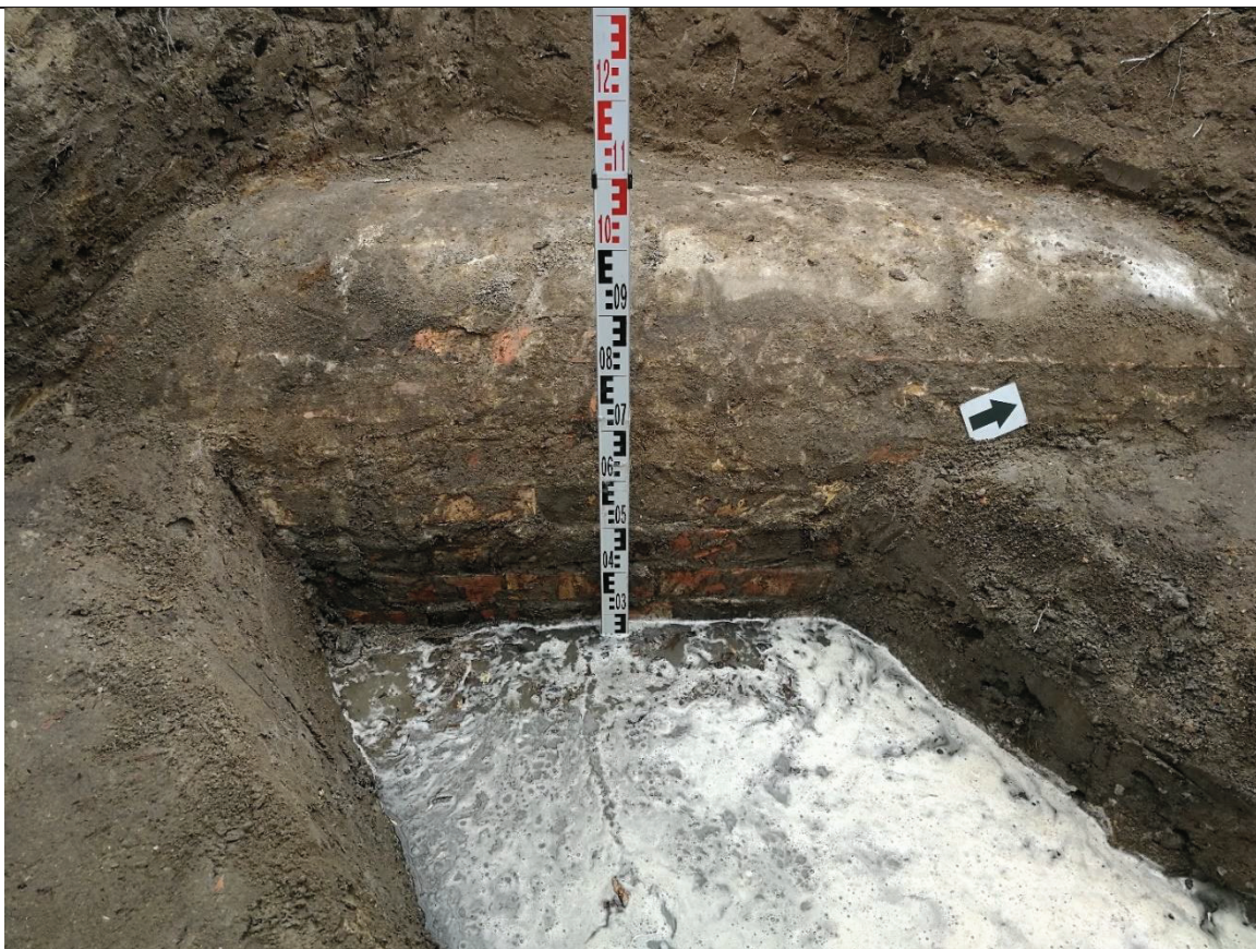
F.04. Šurfe nr. 3 atidengto nuotekų kolektoriaus viršaus ir šoninės, išgaubtos sienos fragmentas.
