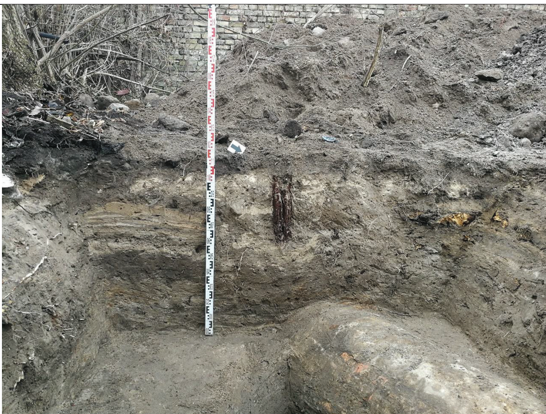
F.05. Šurfe nr. 3 atidengto nuotekų kolektoriaus fragmento pietrytinė dalis. Pjūvio stratigrafijoje išskiriami trijų buvusių kiemo paviršiaus horizontai. Tranšėjos, skirtos kolektoriaus statybai įkasimo viršus fiksuojamas maždaug 30 cm gylyje nuo dabartinio kiemo paviršiaus lygmens.
