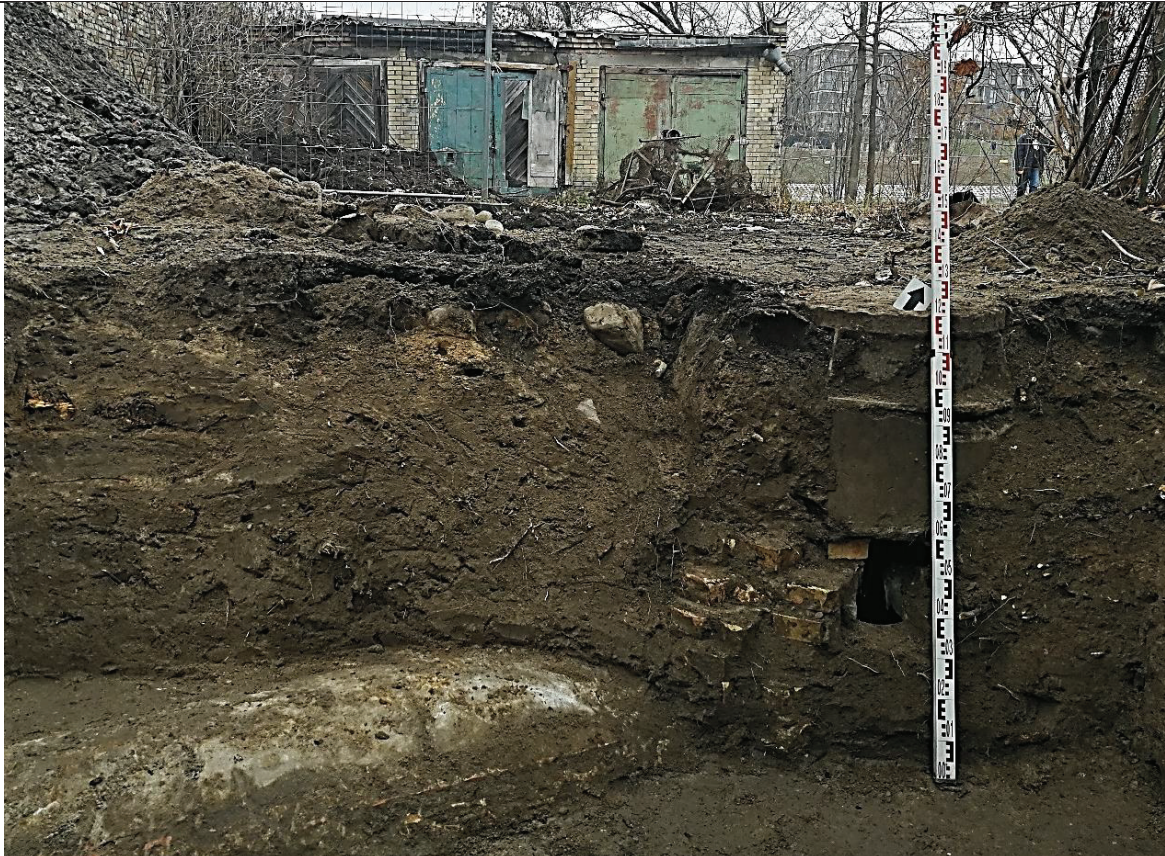
F.02. Šurfe nr. 3 atidengtas nuotekų kolektorius ir šulinys. Vaizdas iš P pusės.
