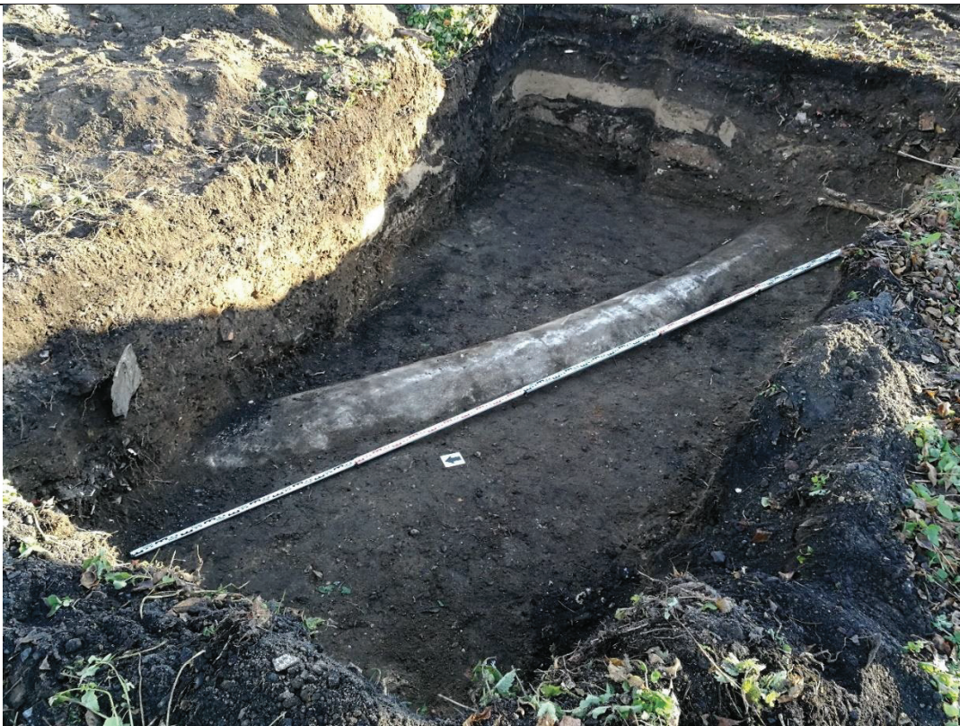
F.07. Perkasa nr. 1. Kolektoriaus viršutinės dalies, pusapvalės formos, betoninio stogo vaizdas iš V pusės.
