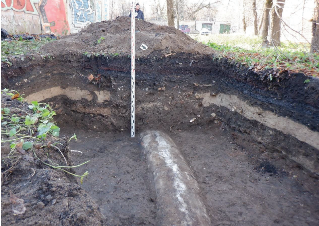
F.06. Perkasoje nr. 1 atidengto nuotekų kolektoriaus fragmento pietrytinė dalis. Pjūvio stratigrafijoje išskiriami dviejų buvusių kiemo paviršiaus horizontai. Tranšėjos, skirtos kolektoriaus statybai įkasimo viršus fiksuojamas maždaug 50 cm gylyje nuo dabartinio kiemo paviršiaus lygmens.
