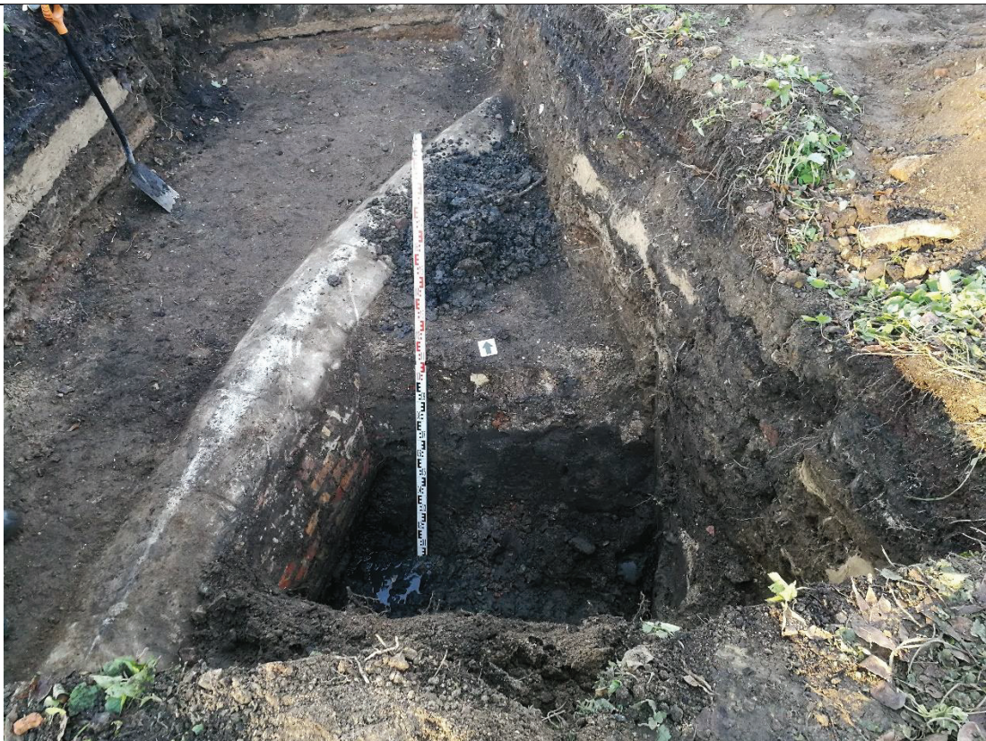
F.08. Perkastos nr. 1 centrinėje dalyje atlikus pasigilinimą, atidengto nuotekų kolektoriaus sienos fragmento ir jos lygmenyje durbingo, drėgno grunto sluoksnio vaizdas iš R pusės.
