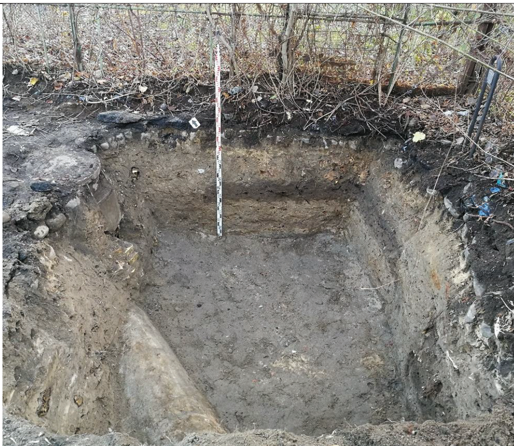
F.01 Šūrfas nr. 3 dugno ir šiaurinio pjūvio vaizdas iš Š pusės. Kairėje pusėje, dugne- atidengto kolektoriaus viršus ir kanalizacijos šulinys, pjūvyje- tranšėjos, skirtos kolektoriaus statybai, ribos.
