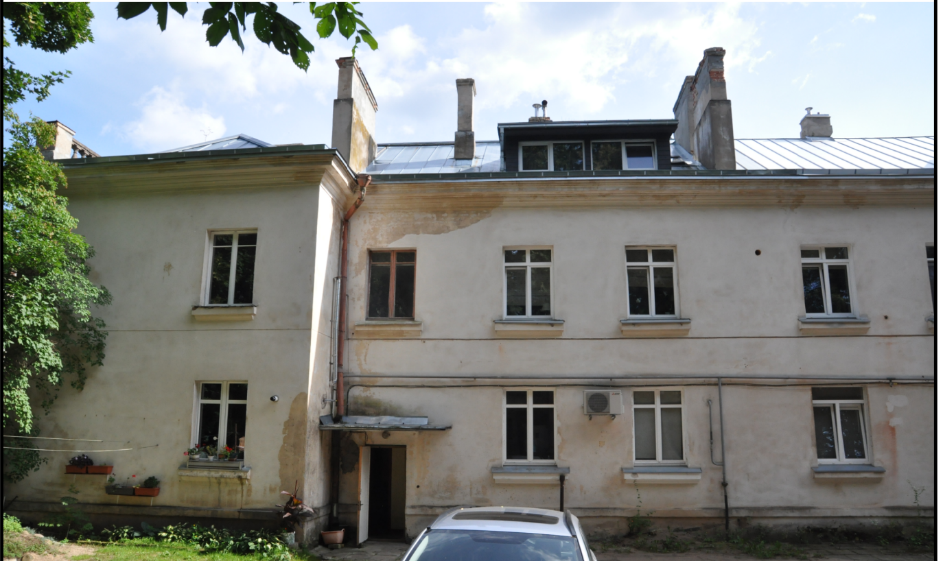
NAMO KAIRĖS PUSĖS KIEMO FASADO FOTOFIKSACIJA
