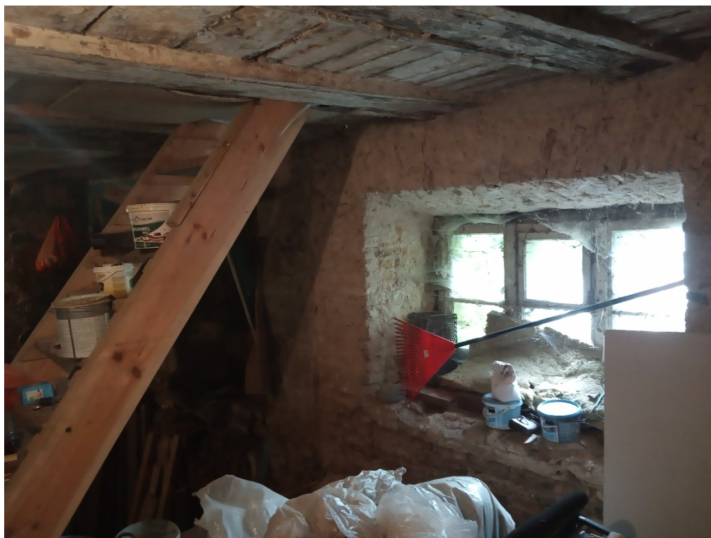
F 3, 4 Užupio g. 7-47 lango pirminio etapo palangė buvo iki dabartinio grindų lygio, o dabartinė palangė suformuota XX a. II p. etape
