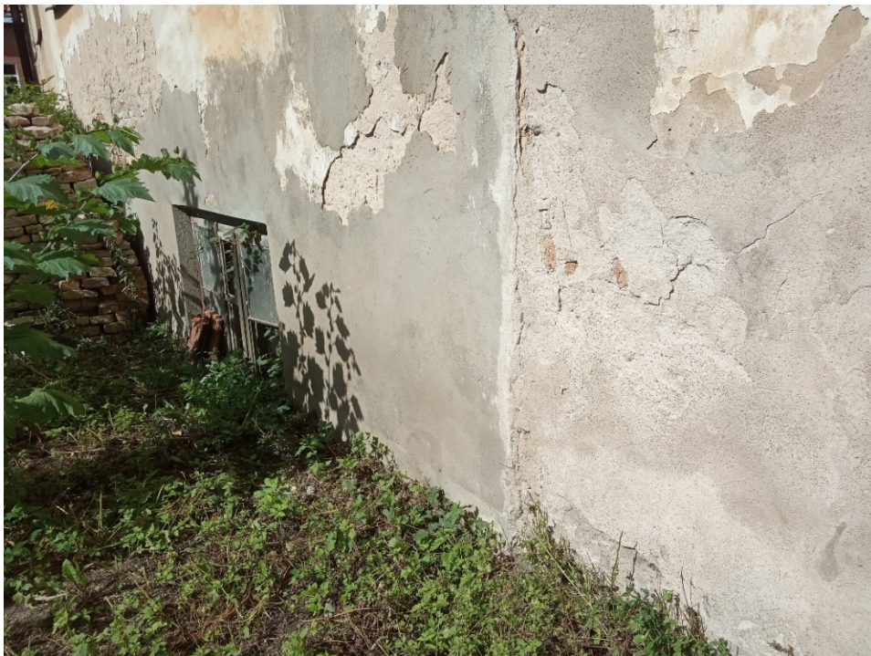
F 2 Tarp esamo lango ir korpuso kampo XIX a. pr.-vid. klasicizmo etape buvo dar vienas cokolinio aukšto langas (jo sąrama matosi savaiminiame zondaže), šis langas užmūrytas XX a. II p. etape
