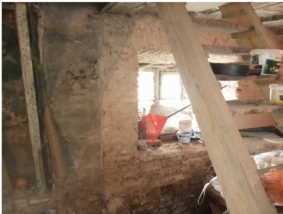
F 3, 4 Užupio g. 7-47 lango pirminio etapo palangė buvo iki dabartinio grindų lygio, o dabartinė palangė suformuota XX a. II p. etape
