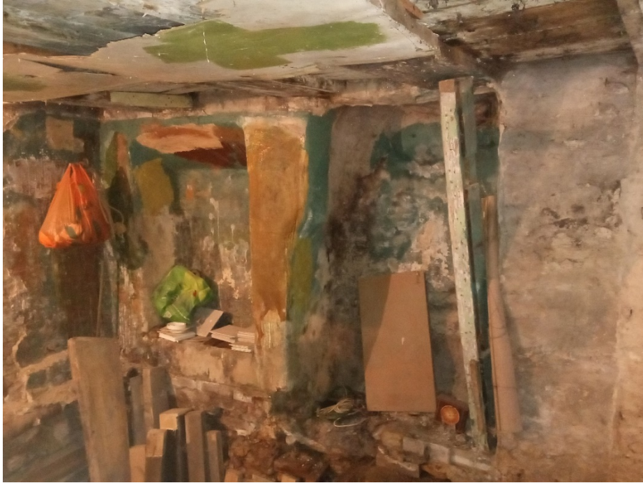
F 5 Užupio g. 7-47 tarp esamo lango ir korpuso kampo XIX a. pr.-vid. klasicizmo etape buvo dar vienas langas, iš vidaus matosi jo pirminiai gabaritai, šis langas užmūrytas XX a. II p. etape
