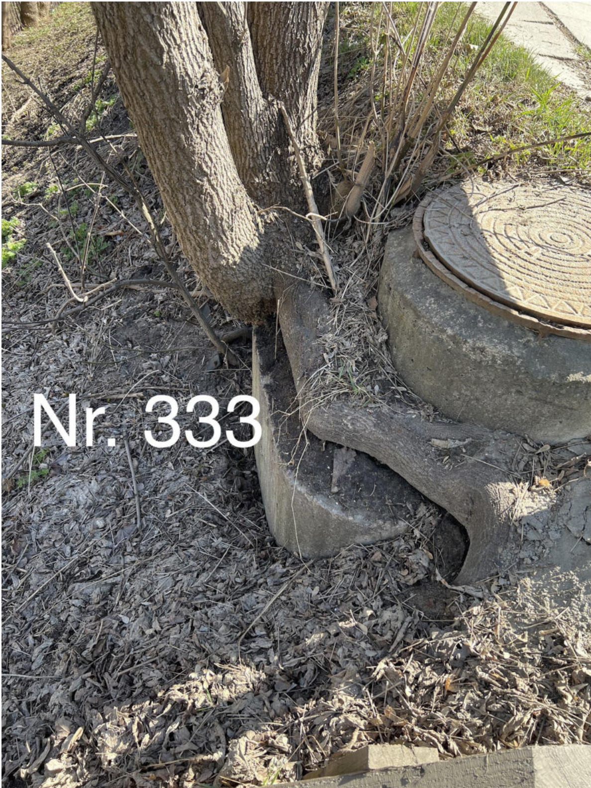
Uosialapis klevas (nr. 333 plane) - auga ant komunikacijų šulinio, šaknys apraizgiusios šulinį. Pietvakarių pusėje šaknų išviso nesimato, nes pagrindinis kamienas praktiškai auga ant šulinio šachtos. Sunku nustatyti tokio medžio pavojingumą ir virtimo galimybę, kuomet šaknų kaklelis yra virš betoninio darinio. Dėl šių priežasčių siūloma šalinti.
