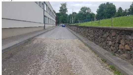
3.17 pav. Esamo geros būklės asfalto jungtis su skaldos danga
