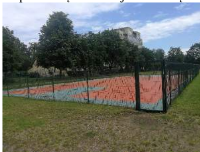
3.10 pav. naujesnė krepšinio aikštelė su gumine, korine plytelių danga
