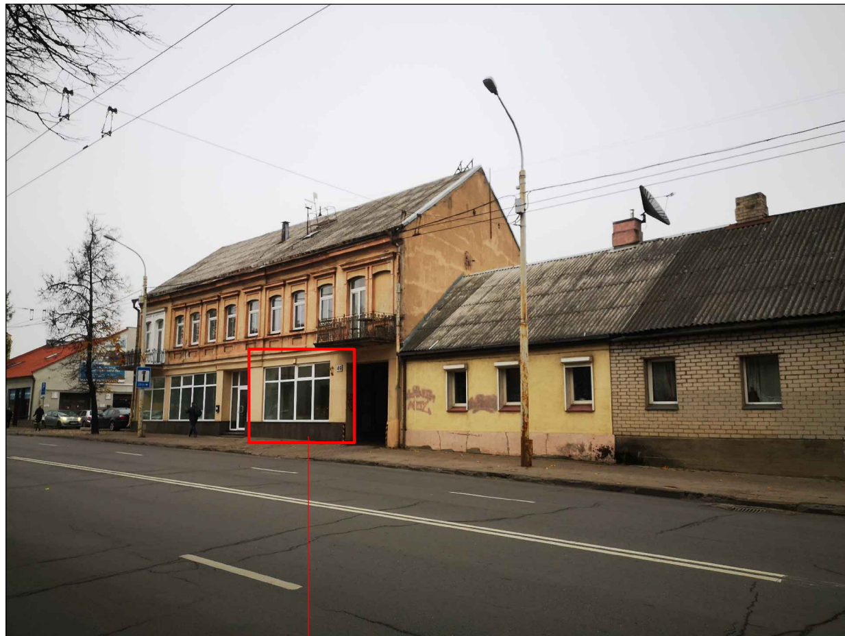
Patalpų vieta pastate
