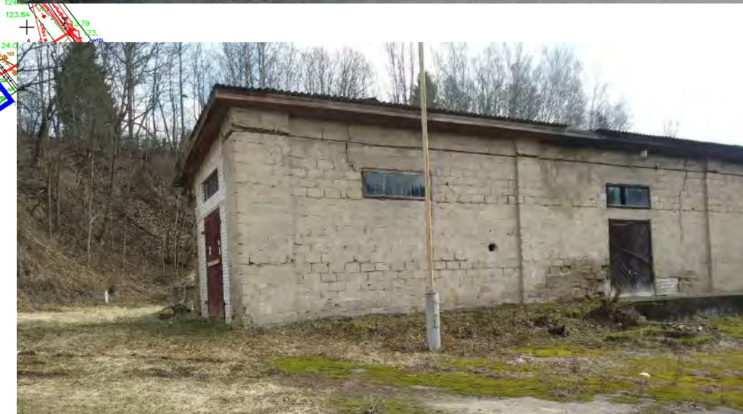
Kapitalinis remontas Griovimas
