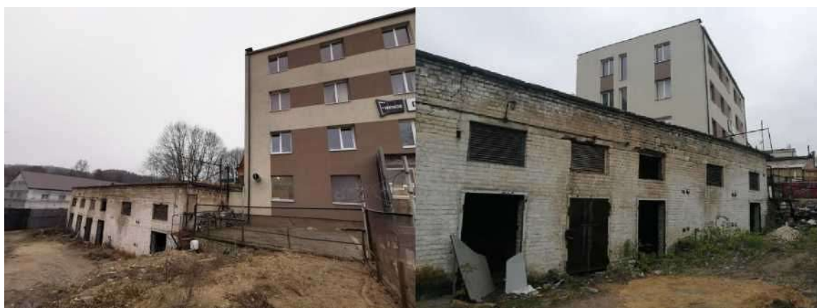
2 pav. — rekonstruojamo sandėlio fotofiksacija kartu su kaimyniniu pastatu
