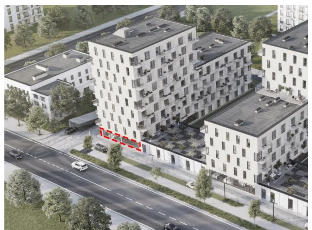
Projektuojamos klinikos vieta iš statybininkų g. pusės
