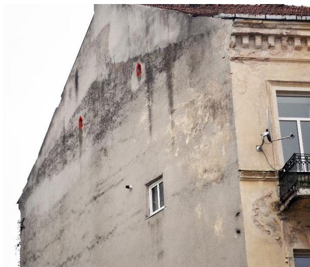
Pastogės vėdinimo angos iki pastato renovacijos
