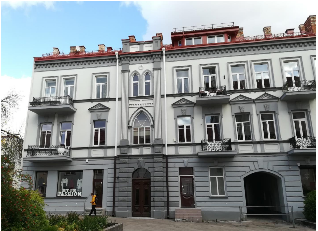
Esamas turinis stoglangis įrengtas nesivadovaujant palėpių ir stoglangių įrengimo vilniaus senamiesčio pastatuose rekomendacijomis.
