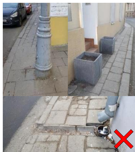
Įvairios kliūtys pėsčiųjų take: apšvietimo stulpai, gėlių vazonai, neuždengtas lietaus vandens nuvedimo latakas
