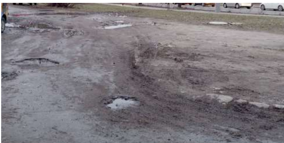
Asfalto dangos pravažiavimas
