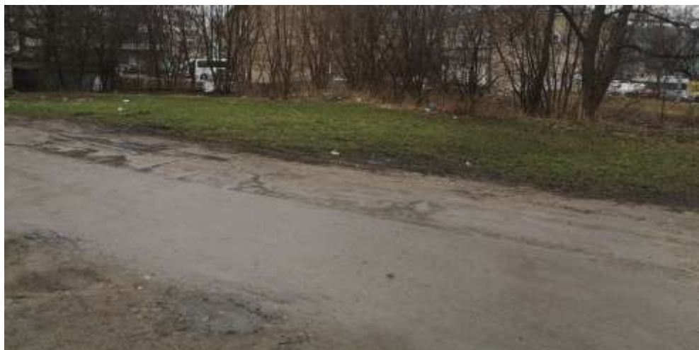
Asfalto dangos pravažiavimas
