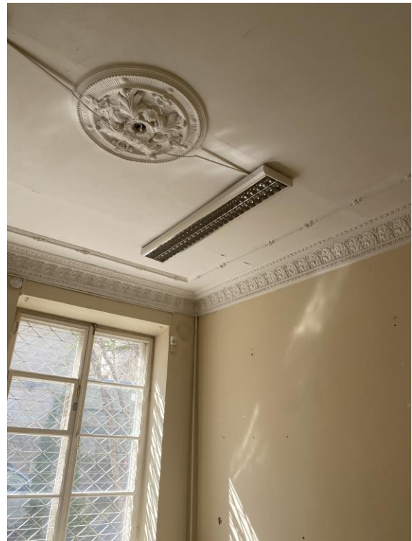
Esama padėtis. Patalpa 5-7
