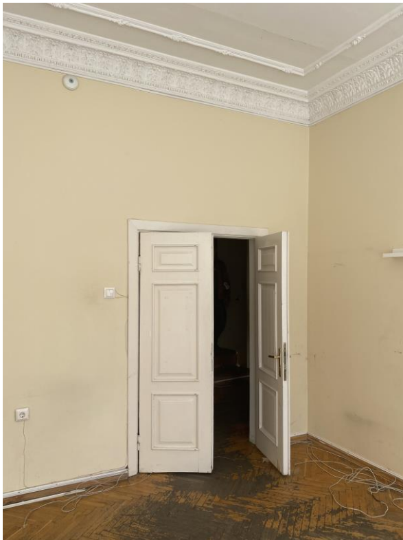
Esama padėtis. Patalpa 5-8
