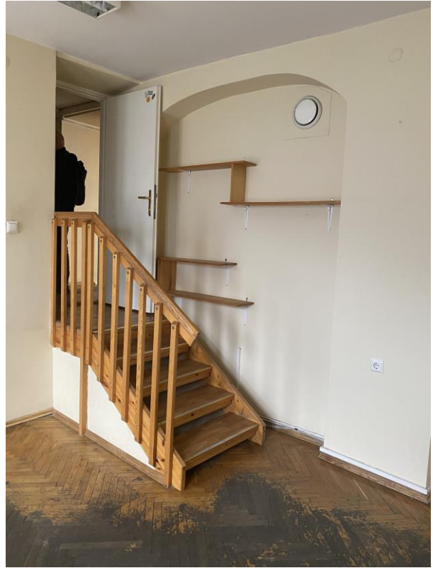
Esama padėtis. Patalpa 5-5
