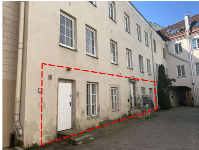
Pagrindiniai įėjimai į esamas administracines patalpas. Vaizdas iš kiemo, šiaurinis fasadas
