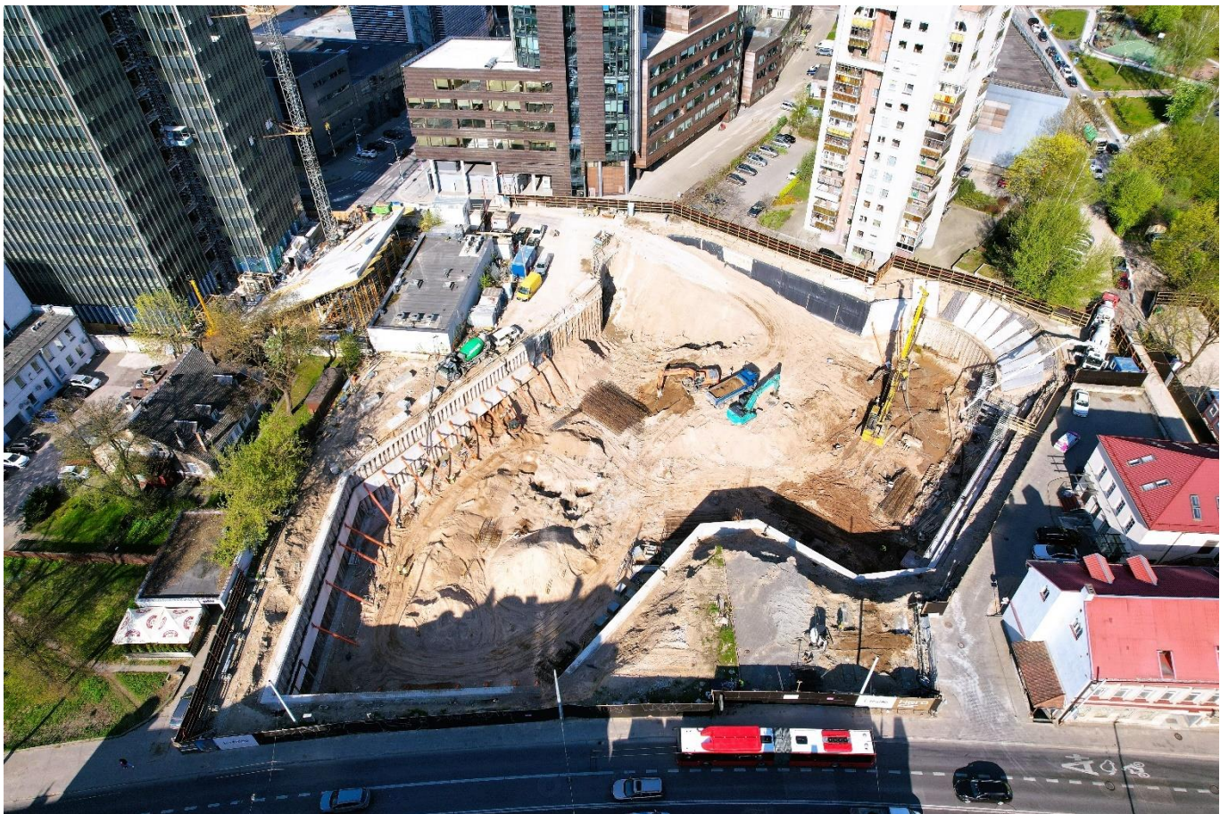
Fotofiksacija iš drono (2023-04-26, statybos darbai vykdomi pagal statybos leidimą Nr.: LSNS-01-220406-00418)
