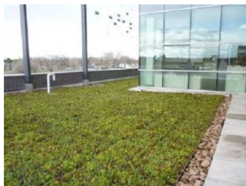
3.1 AUKŠTO KOMERCINIŲ PATALPŲ STOGAS APŽELDINAMAS
