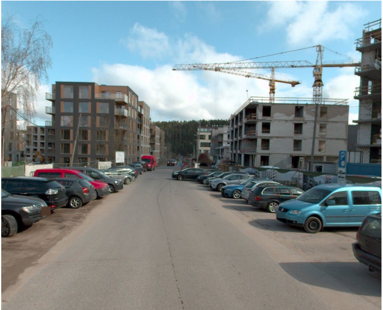
1 pav. Esama gatvės situacija
