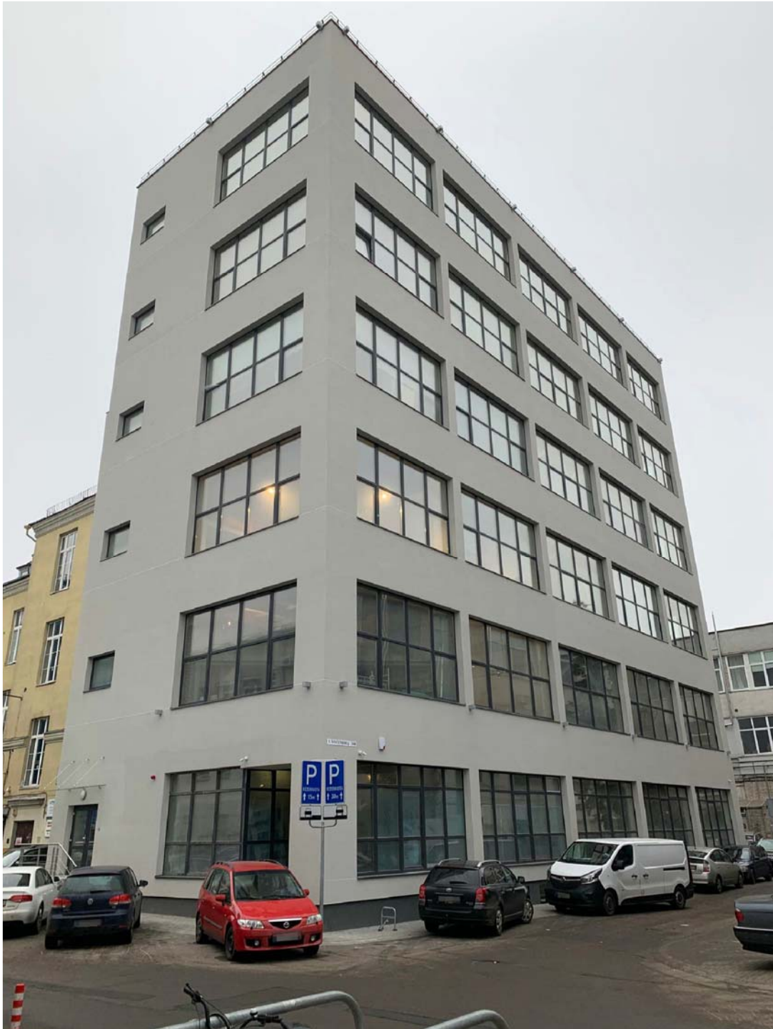
Remontuojamos pirmo aukšto patalpos
