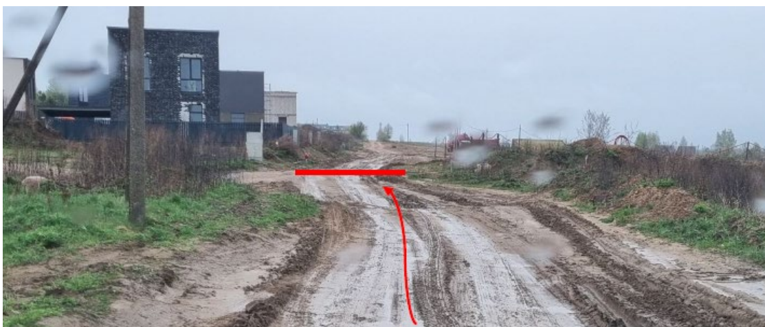
11 pav. Keltų gatvės fotonuotrauka. Projektuojamos Keltų gatvė darbų ruožo pabaiga
