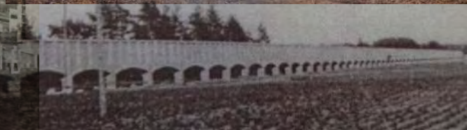
Gelžbetonis akvedukas 1935m (apačioje) , dabar viaduko arkose įsikūrę sandėliai ir garažai (viršuje)
