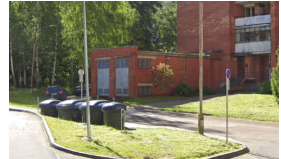
A5 BUITINIŲ ATLIĘKŲ KONTEJNERIAI IR A6 ELEKTROS TRANSFORMATORIŅE
