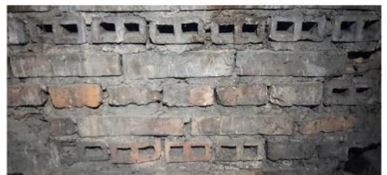
Tuštumėtų plytų fragmentai palėpėje
