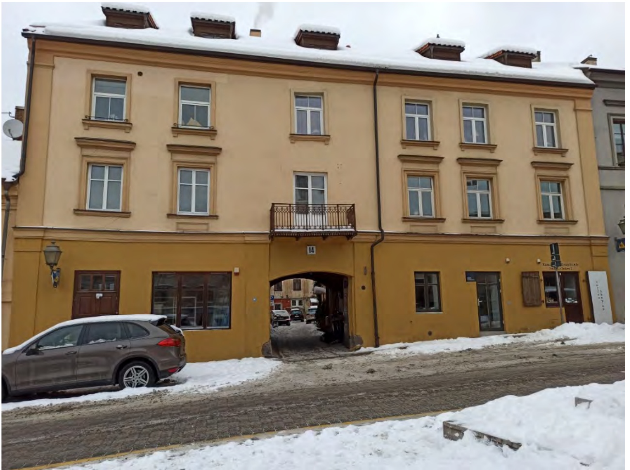
3 pav. Pastato fasadas.
