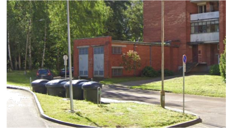
A5 BUITINIŲ ATLIEKŲ KONTEINERIAI IR A6 ELEKTROS TRANSFORMATORINĖ
