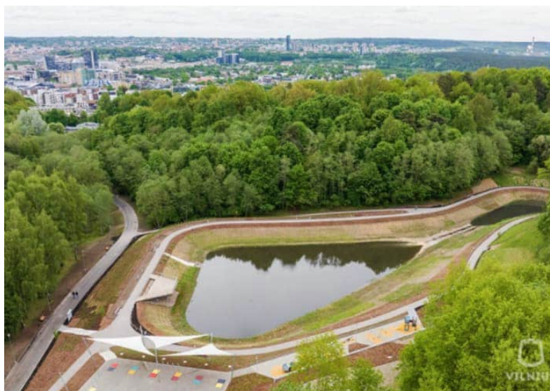
3.1 pav. Įrengta paviršinių nuotekų kaupykla Siesikų g. (Šaltinis: https://www.grinda.lt )
