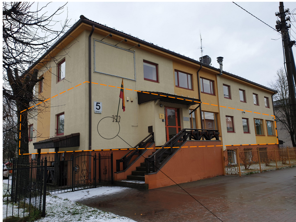
Šiaurės fasadas - vakarų fasadas
