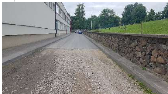
3.17 pav. Esamo geros būklės asfalto jungtis su skaldos danga
