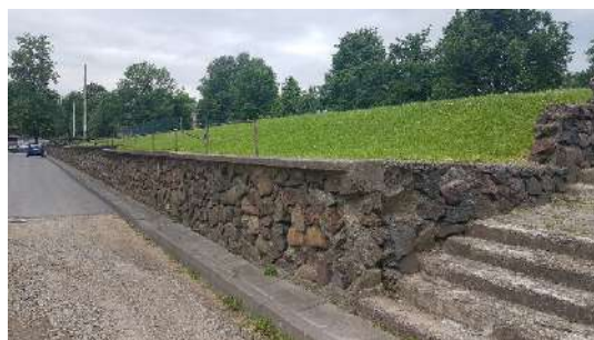
3.13 pav. Akmeninė atraminė sienutė
