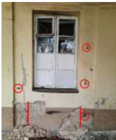
C Buvusi durų anga su išlikusiais vinių kabilais ir spygnos pakabinimu
