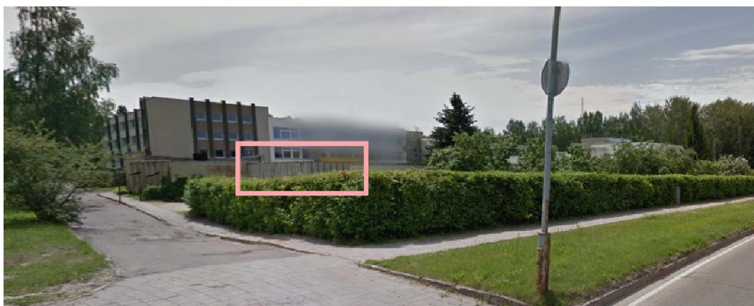
Remontuojamos patalptos šiaurinėje pastato dalyje – korpuse, kuris yra vieno aukšto.
