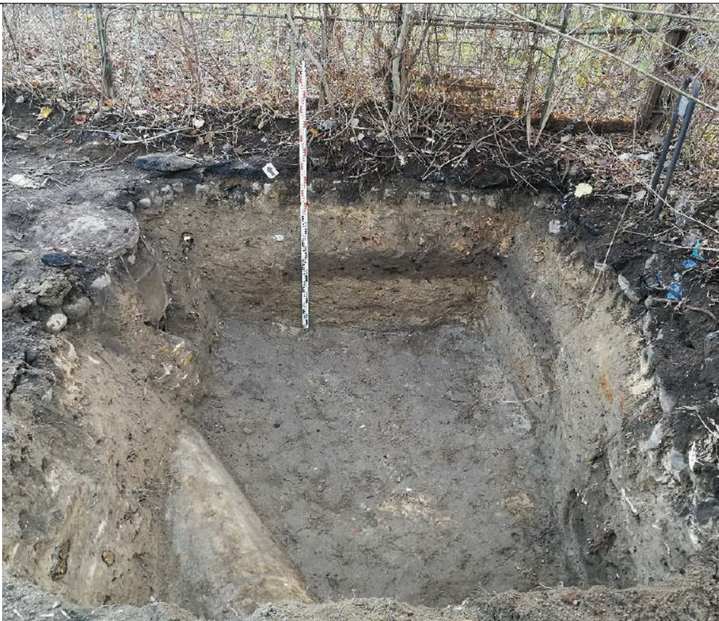
F.01 Šurfas nr. 3 dugno ir šiaurinio pjūvio vaizdas iš Š pusės. Kairėje pusėje, dugne- atidengto kolektoriaus viršus ir kanalizacijos šulinys, pjūvyje- tranšėjos, skirtos kolektoriaus statybai, ribos.
