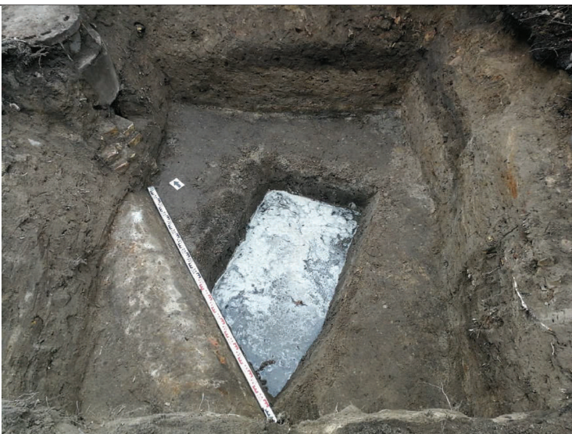
F.03. Šurfas nr. 3 dugne atidengto kolektoriaus viršaus ir šalimais iškasto šurfo, užpildyto gruntiniu vandeniu, vaizdas iš viršaus.
