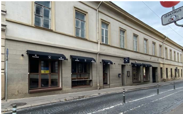
u/nr. 1094-0442-4015 gatvės fasadas
