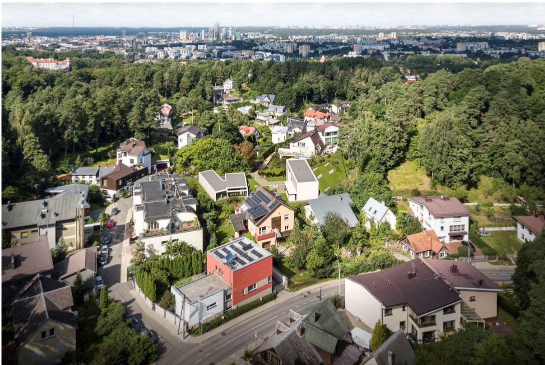
3 pav. pastato tūris aplinkoje (vaizdas iš rytų pusės)
