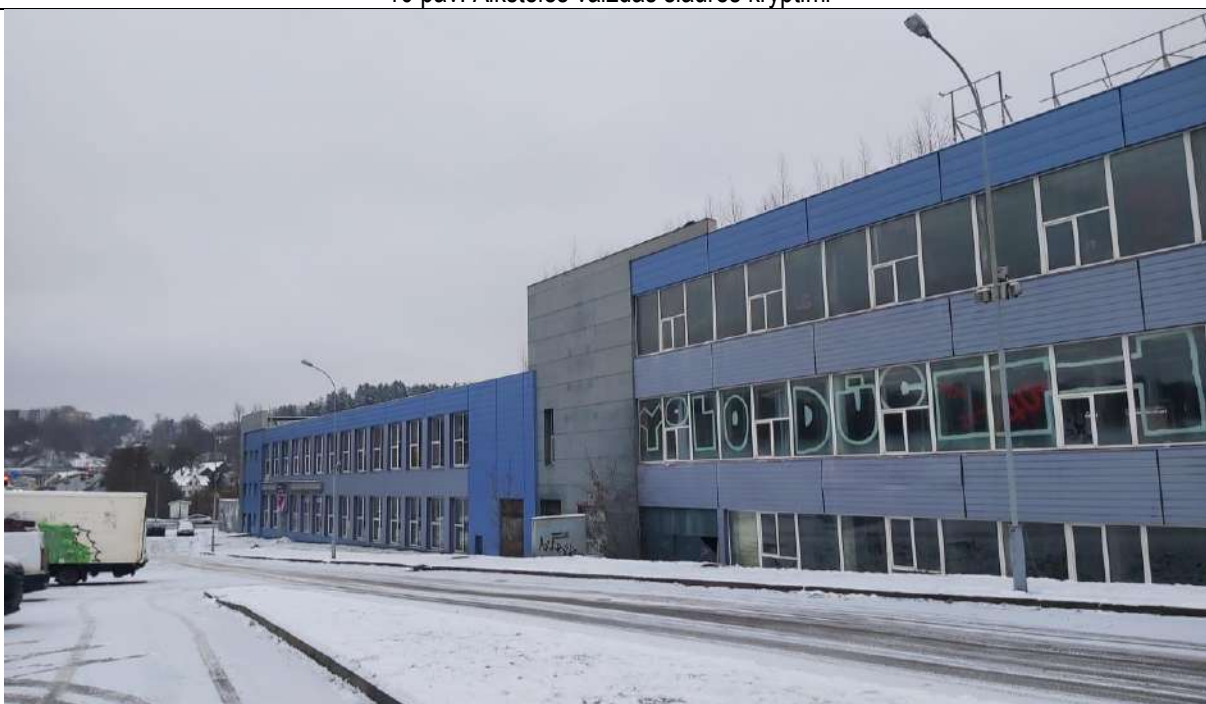
11 pav. Aikštelės vaizdas šiaurės kryptimi
