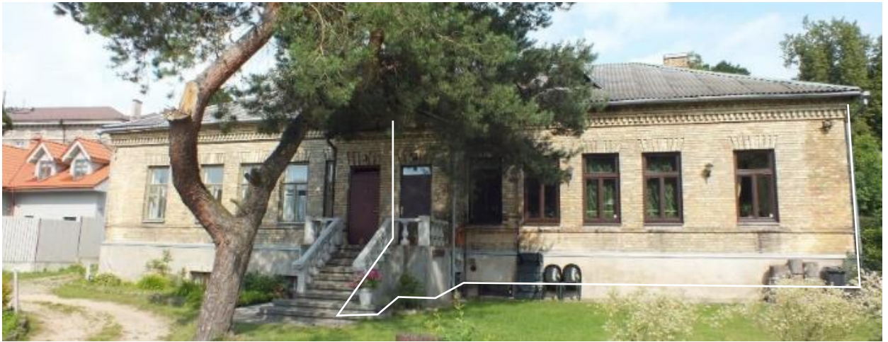
Stogas valminis ,dalis stogo dengta asbestiniu šiferiu, dalis dengta neasbestiniu šiferiu
