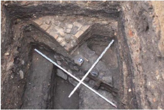
pav. 1 Šurfo Nr. 1 aptikta mūro konstrukcija
