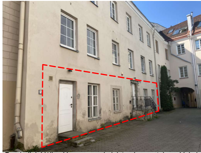
Pagrindiniai įėjimai į esamas administracines patalpas. Vaizdas iš kiemo, šiaurinis fasadas
