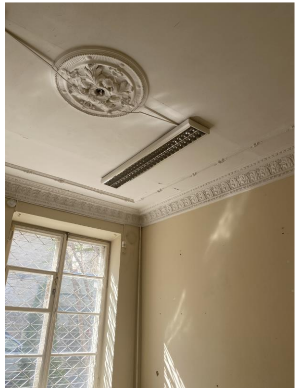
Esama padėtis. Patalpa 5-7
