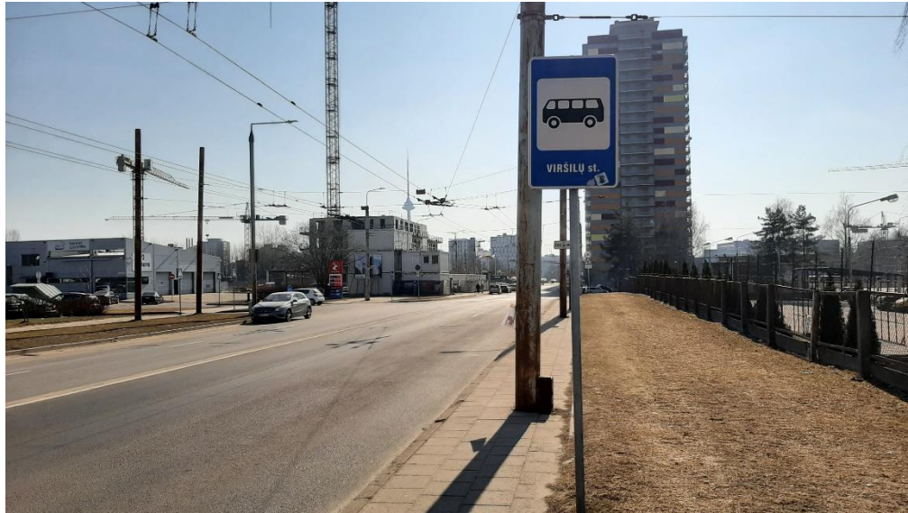
2 pav. Esama Viršilų gatvės padėtis ruožo pradžioje
