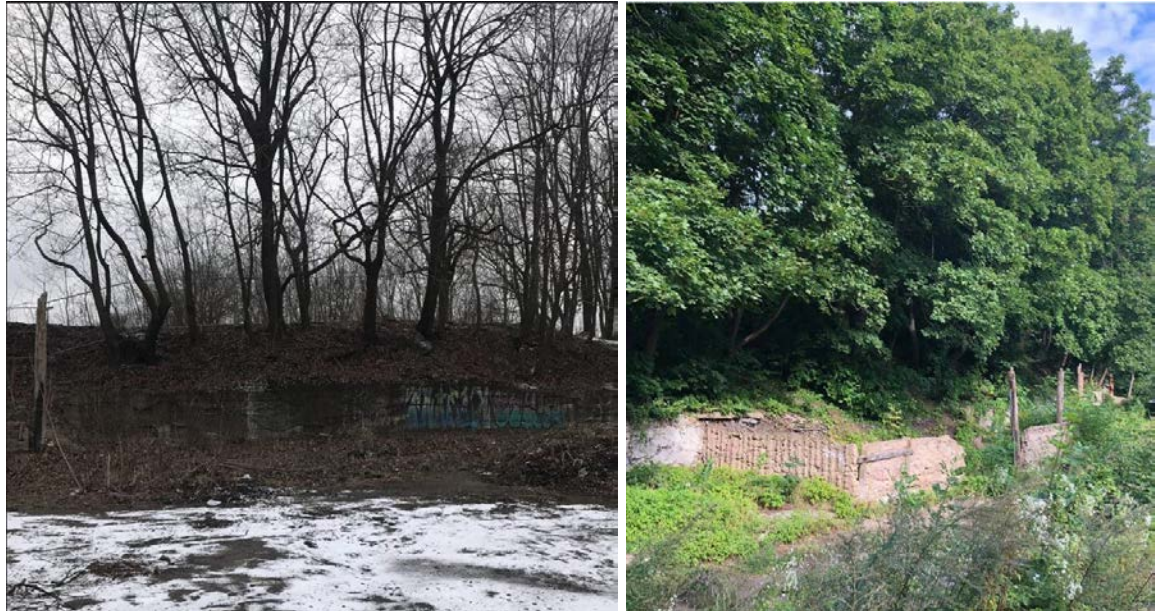
K. Vanagėlio g. 11 sklypo vakarų pusėje šlaitą laikančios esamos atraminės sienos
